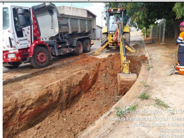
Foto 04 – Tratamento de base profundo (Atual)
