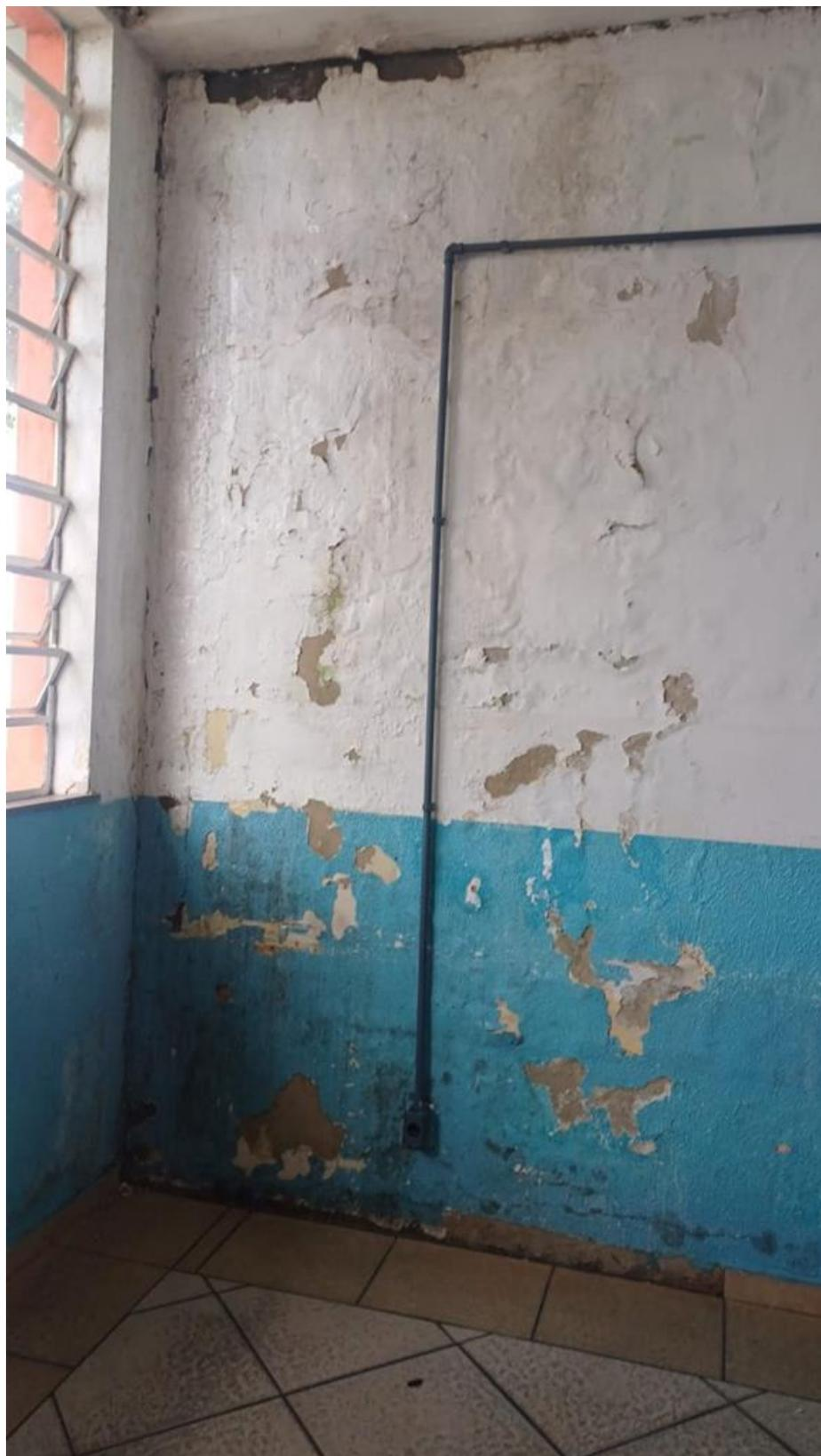
*Parede com infiltração.*
