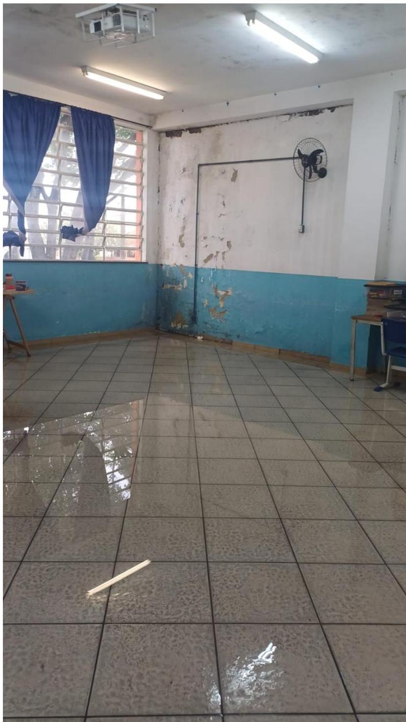
*Paredes com infiltração e piso alagado.*
