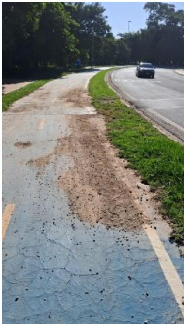
*Pista necessita de revitalização asfáltica e Limpeza.*
