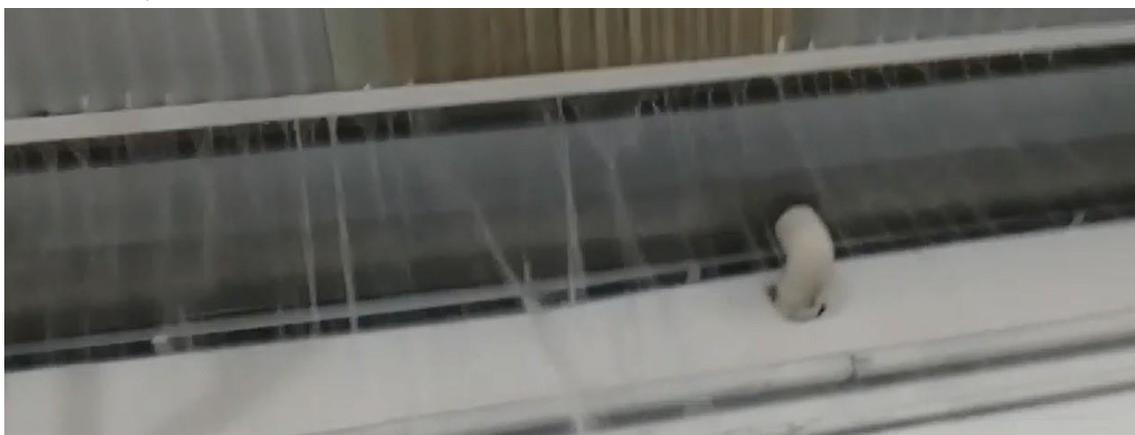
CONSIDERANDO que boa parte da escola foi afetada com a chuva adentrando ao local causando diversos tipos de prejuízos, que possivelmente teriam sido evitados com a devida manutenção do sistema de calha,
