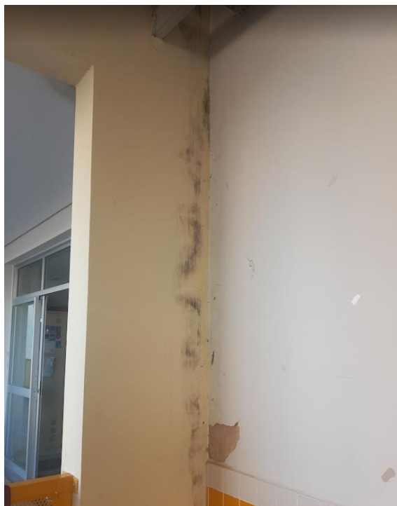
Embolso da parede se desfazendo
