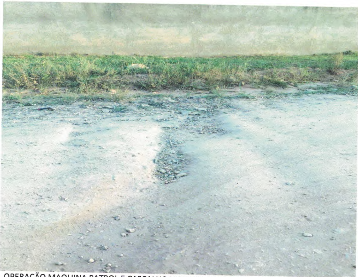
OPERAÇÃO MAQUINA PATROL E CASCALHO VISANDO REPARO EM TODA EXTENSÃO DA RUA FELIPE MOISES BETTI FILHO, LOCALIZADA NO BAIRRO IPANEMA DO MEIO.
