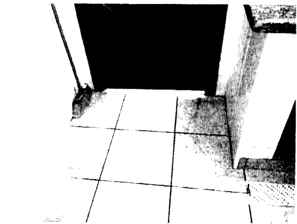
Base da porta da cozinha sem proteção contra insetos
