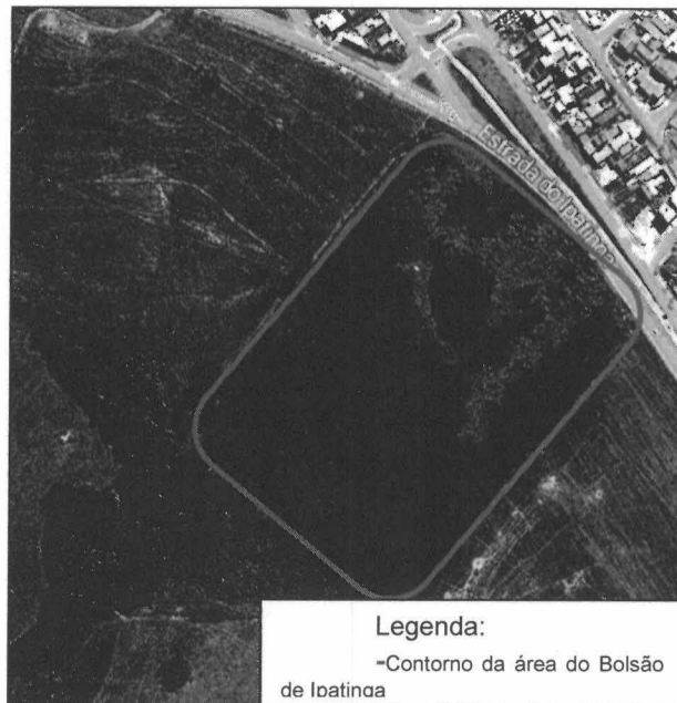
Figura 5.41 - Área do Bolsão de Entulho de Ipatinga. Fonte: Google Earth, 2014.
