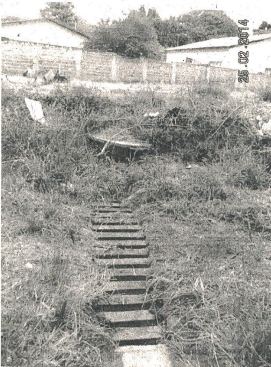
TUBULAÇÃO DO SAAE PASSANDO AO LADO DO TERRENO
