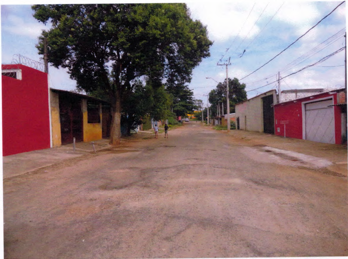
REVITALIZAÇÃO E RECAPE DA RUA SEVERIANO RODRIGUES ALVES LOCALIZADA NO BAIRRO NOVA SOROCABA.
