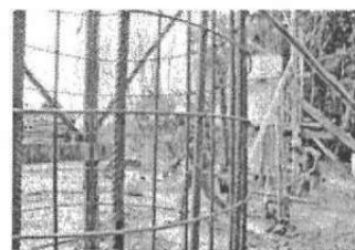
Nova ponte em Pinheiros beneficiará trânsito no Além Ponte
