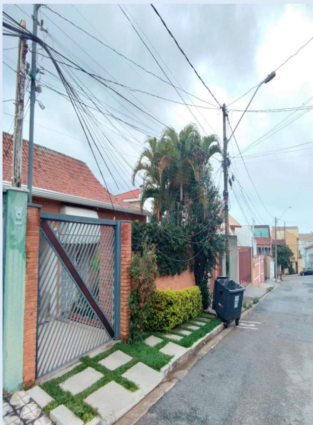
CABOS ROMPIDOS, CABOS BAIXOS, ESPINAR CABOS
