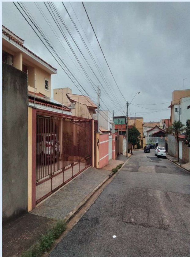
CABOS ROMPIDOS, CABOS BAIXOS, ESPINAR CABOS
