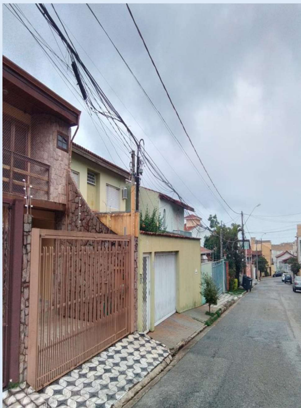
CABOS ROMPIDOS, CABOS BAIXOS, ESPINAR CABOS
