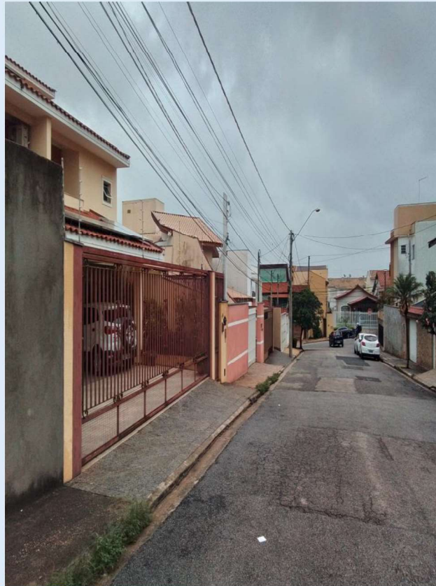
CABOS ROMPIDOS, CABOS BAIXOS, ESPINAR CABOS
