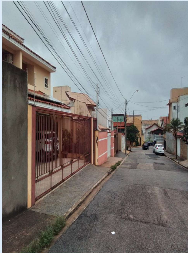
CABOS ROMPIDOS, CABOS BAIXOS, ESPINAR CABOS
