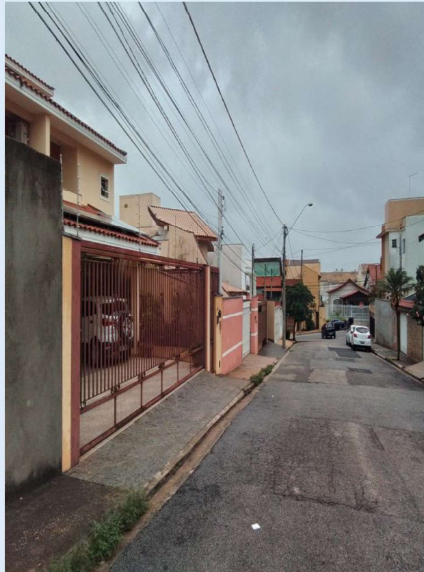
CABOS ROMPIDOS, CABOS BAIXOS, ESPINAR CABOS
