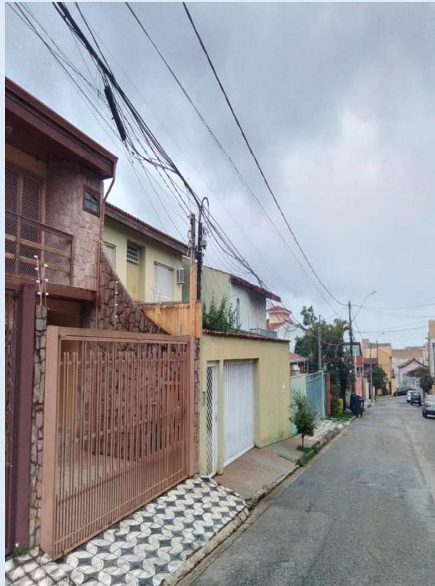
CABOS ROMPIDOS, CABOS BAIXOS, ESPINAR CABOS
