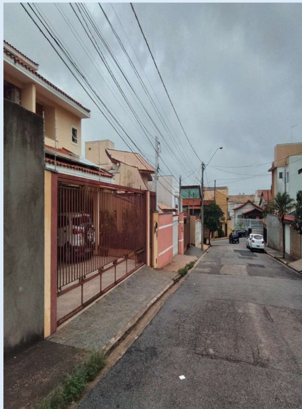
CABOS ROMPIDOS, CABOS BAIXOS, ESPINAR CABOS
