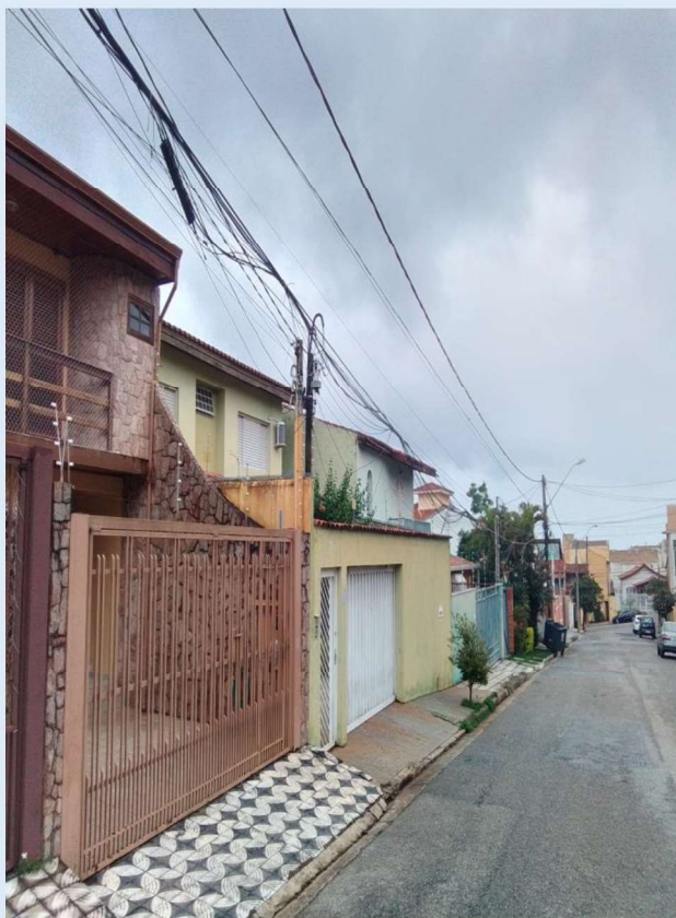
CABOS ROMPIDOS, CABOS BAIXOS, ESPINAR CABOS
