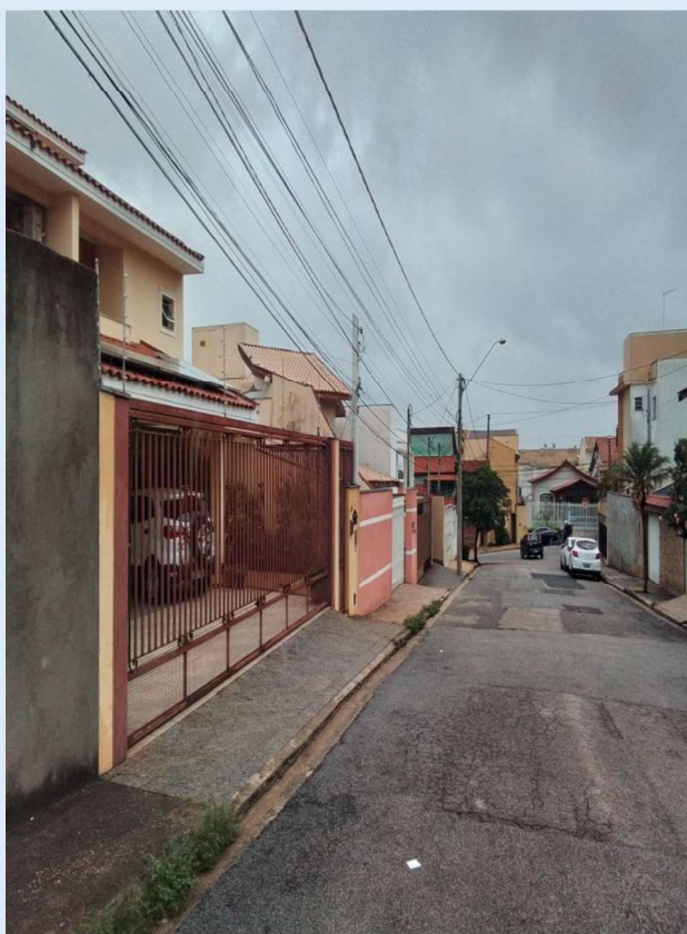
CABOS ROMPIDOS, CABOS BAIXOS, ESPINAR CABOS
