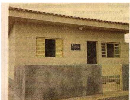
A zeladoria foi construída com a mão-de-obra da Prefeitura e material arrecadado pelo Manchester.
