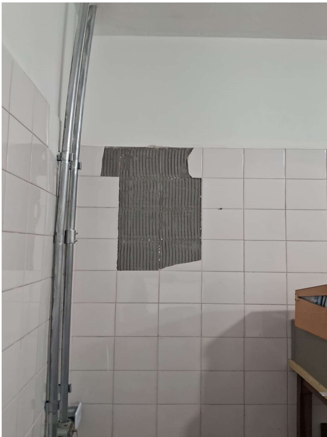
REVESTIMENTO SALA DE VACINA
